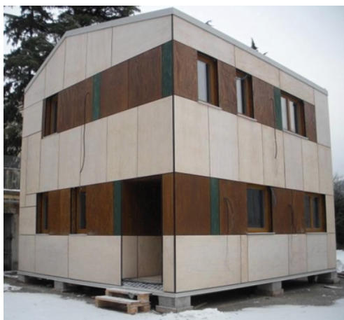
Figura 9 – Edificio prototipo – Fotografia in corrispondenza dell'ingresso.
